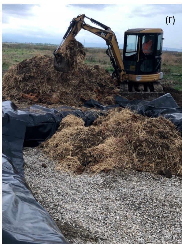
Εικόνα 5. Εικόνες από την ανάμειξη του βιοργανικού πληρωτικού υλικού των βιοκλινών αποτελούμενο από έδαφος/άχυρο/εξαντλημένο υπόστρωμα μανιταριών (Α) και τα στάδια πλήρωσης της βιοκλίνης με το υλικό αυτό (Β έως Δ).
