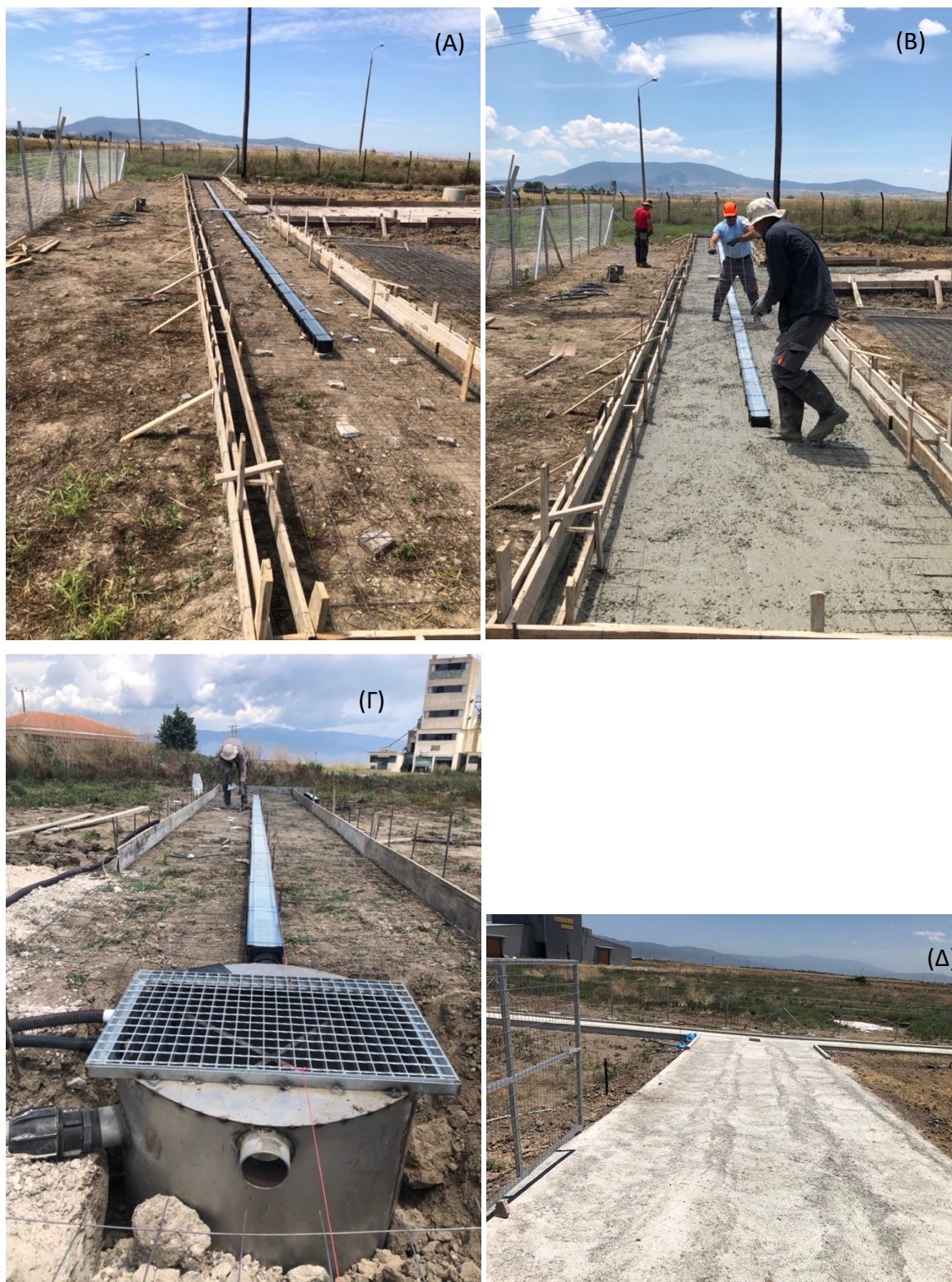
Εικόνα 3. Εικόνες από τα στάδια κατασκευής της τσιμεντένια πλατείας των βιοκλινών όπου γίνονται οι διεργασίες ξεπλύματος των ψεκαστικών μηχανημάτων, όπως η οριοθέτηση της πλατείας (Α), καλούπωμα και τοποθέτηση μεταλλικής σχάρας συλλογής αποβλήτων (Β), τοποθέτηση ανοξείδωτης μικρής δεξαμενής συγκέντρωσης των αποβλήτων (Γ) και η επίστρωση με κατάλληλο τσιμέντο (Δ).
