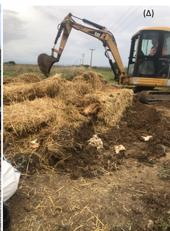
Εικόνα 5. Εικόνες από την ανάμειξη του βιοργανικού πληρωτικού υλικού των βιοκλινών αποτελούμενο από έδαφος/άχυρο/εξαντλημένο υπόστρωμα μανιταριών (Α) και τα στάδια πλήρωσης της βιοκλίνης με το υλικό αυτό (Β έως Δ).
