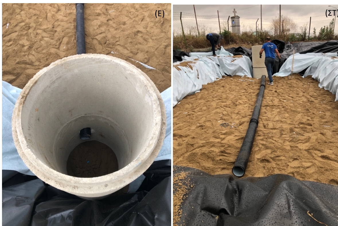
Εικόνα 4. Εικόνες από την οριοθέτηση και κατασκευή του ορύγματος της βιοκλίνης, καθώς επίσης και από την επίστρωση των μονωτικών υλικών για την αποφυγή έκπλυσης των υγρών αποβλήτων στο υπόγειο υδροφόρο ορίζοντα.
